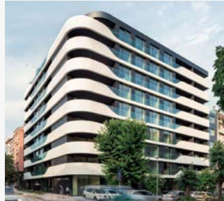
Varna Wave Building. Beboelsesbygning. Varna, Bulgary. Aquarea og Aquarea Smart Cloud.
